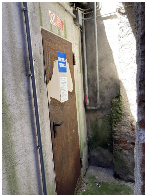
Figura 13: Porta tagliafuoco attuale e sistema di adduzione gas metano con saracinesca
