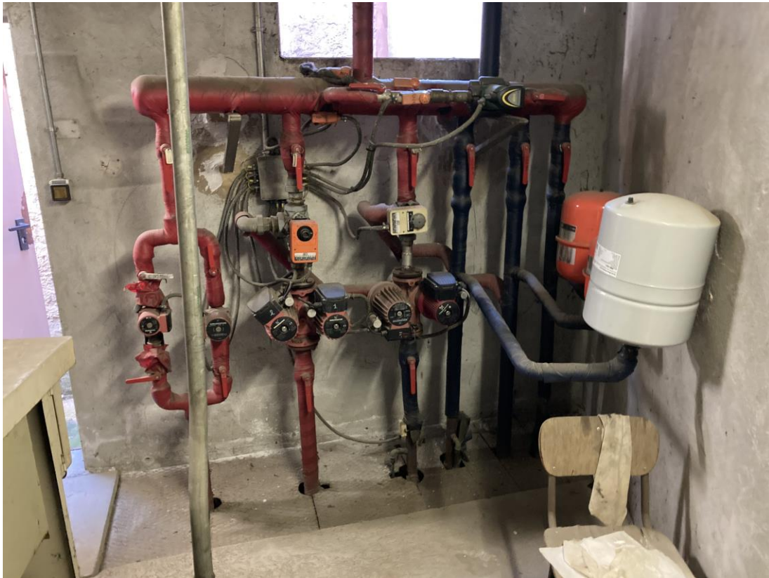
Figura 12: Attuale sistema di distribuzione con pompe di circolazione
