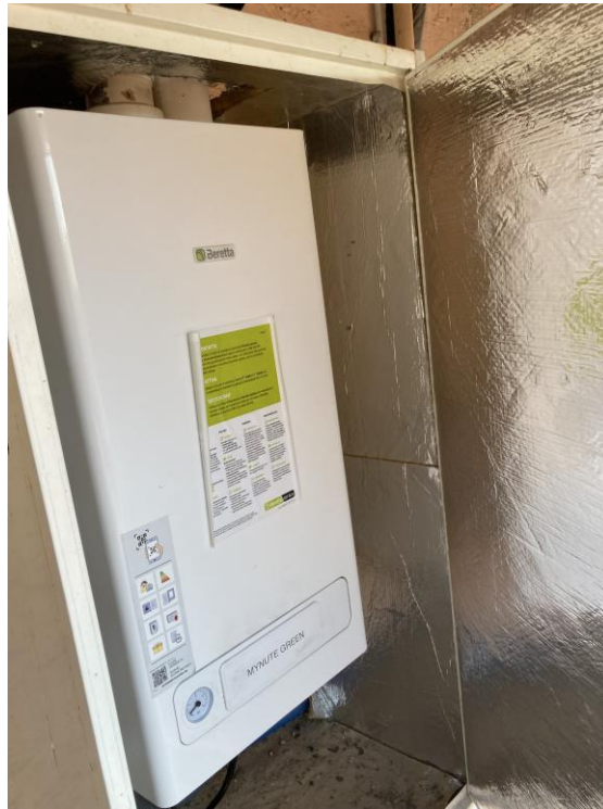
Figura 14: Caldaia a condensazione provvisoria per locale principale museo
