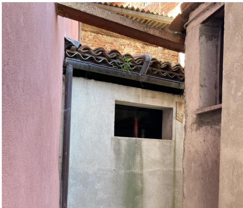
Figura 10: Vista attuale sistema di copertura con coppi e lastre contenenti amianto
